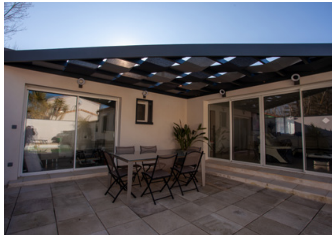
Pergola avec une structure en aluminium et des toiles tressées. Forme triangulaire.
